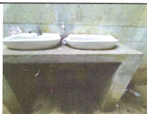
FOTO 4.: SERVICIOS SANITARIOS Y SUS ACCESORIOS. Sustitución de accesorios de lavamanos.
