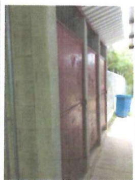
FOTO 1.: PUERTAS. Mantenimiento a puertas metálicas existentes, retiro de óxido, suciedad y pintura deteriorada, incluye cepillado, lijado y aplicación de pintura
