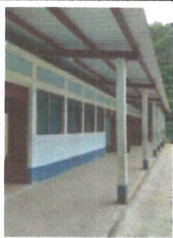
FOTO 5.: PINTURA EN MUROS INTERIOR Y EXTERIOR Preparación de la superficie y aplicación de pintura a dos manos, en paredes interiores y exteriores del establecimiento.
