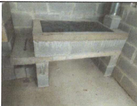
FOTO 3.: REPARACIÓN O SUSTITUCIÓN DE ÁREA DE COCINA. Mantenimiento de estufa rural con chimenea, plancha y accesorios.
