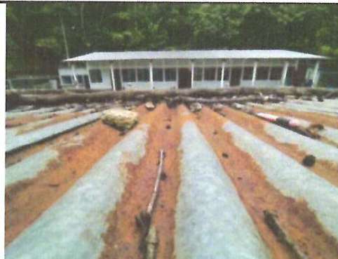
FOTO 2.: ESTRUCTURA Y CUBIERTA, Sustitución de estructura de techo en mal estado, sustitución de lámina en mal estado
